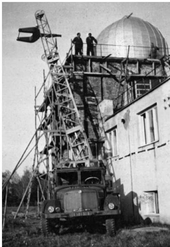
Pro stavbu budovy Lidové hvězdárny byla potřebná i těžká technika. Zdroj: archiv MGP.
