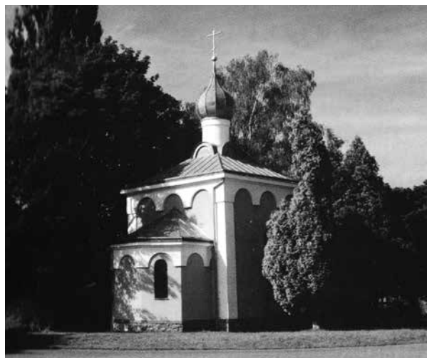
Kaple sv. Trojice v Čelechovicích na Hané. Zdroj: archiv autora.
