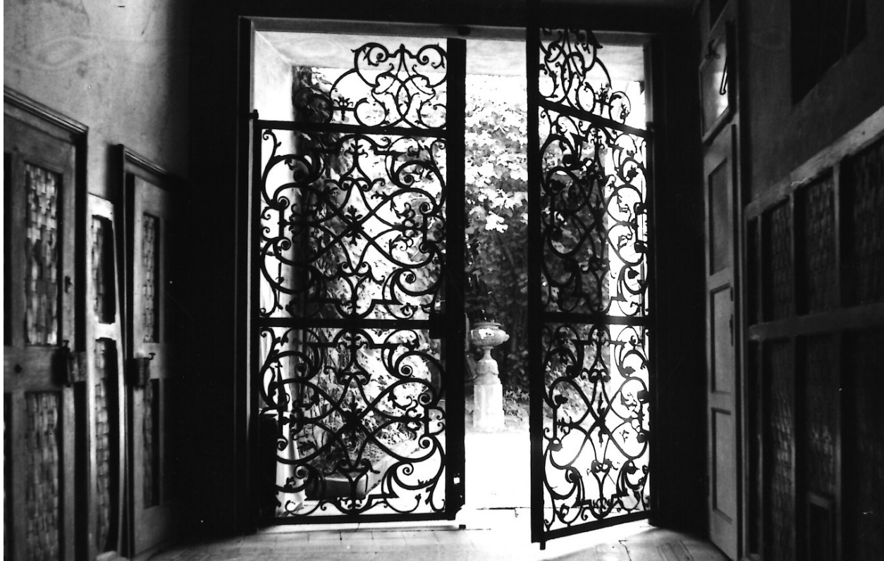
Demolovaný dům s někdejší vodo- a vzucholečbou lékaře Krause na ulici Brněnská. Zdroj: fond Městský národní výbor Olomouc, SOkA Olomouc (NAD 33, značka fondu M 1-33), stavební demolice.
