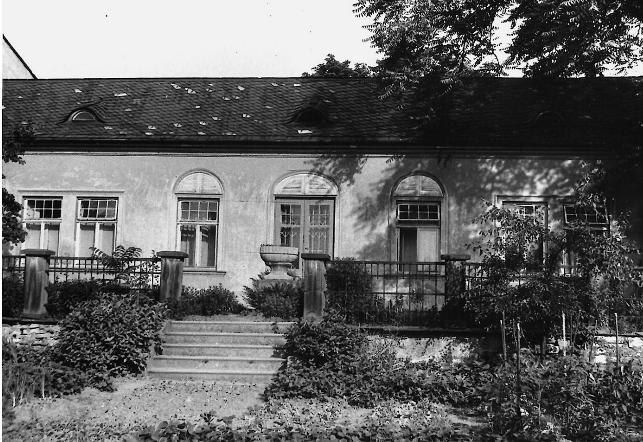
Demolovaný dům s někdejší vodo- a vzducholéčbou lékaře Krause na ulici Brněnská. Zdroj: fond Městský národní výbor Olomouc, SOkA Olomouc (NAD 33, značka fondu M 1-33), stavební demolice.
