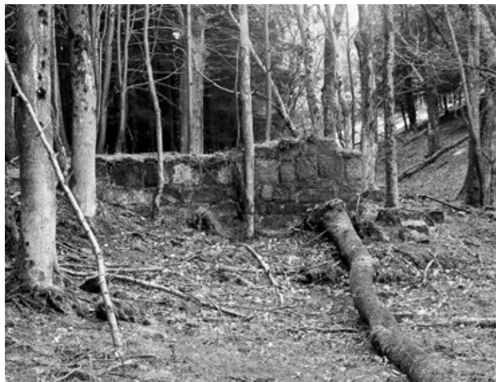
Kamenné základy bývalého stavení v osadě Myslivecká paseka. Foto: Pavel Macháček.
