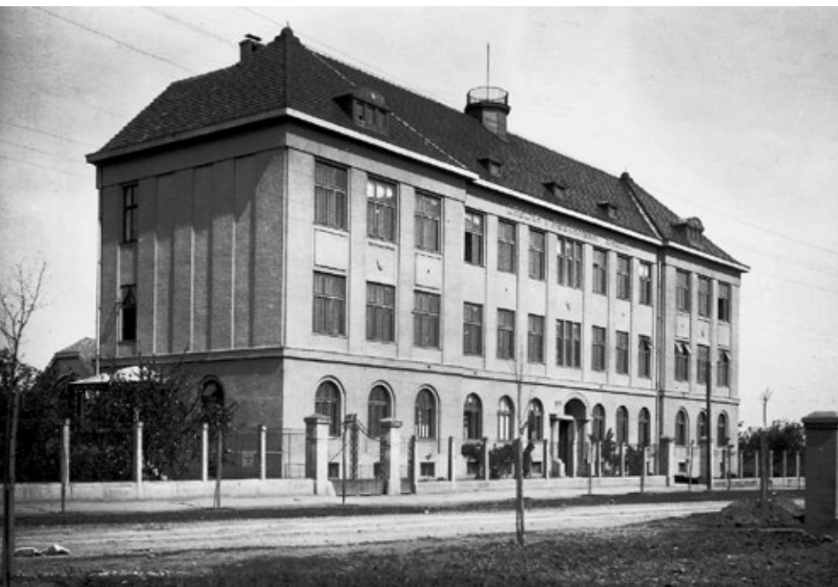
Nová školní budova v Bedihošti, 1916. Zdroj: SOKA Prostějov.
