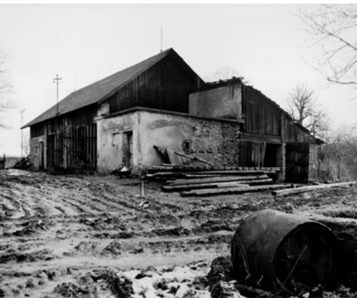
Bývalá usedlost v Símři č. p. 1, snímek ze šedesátých let 20. století. Zdroj: SOkA Přerov.
